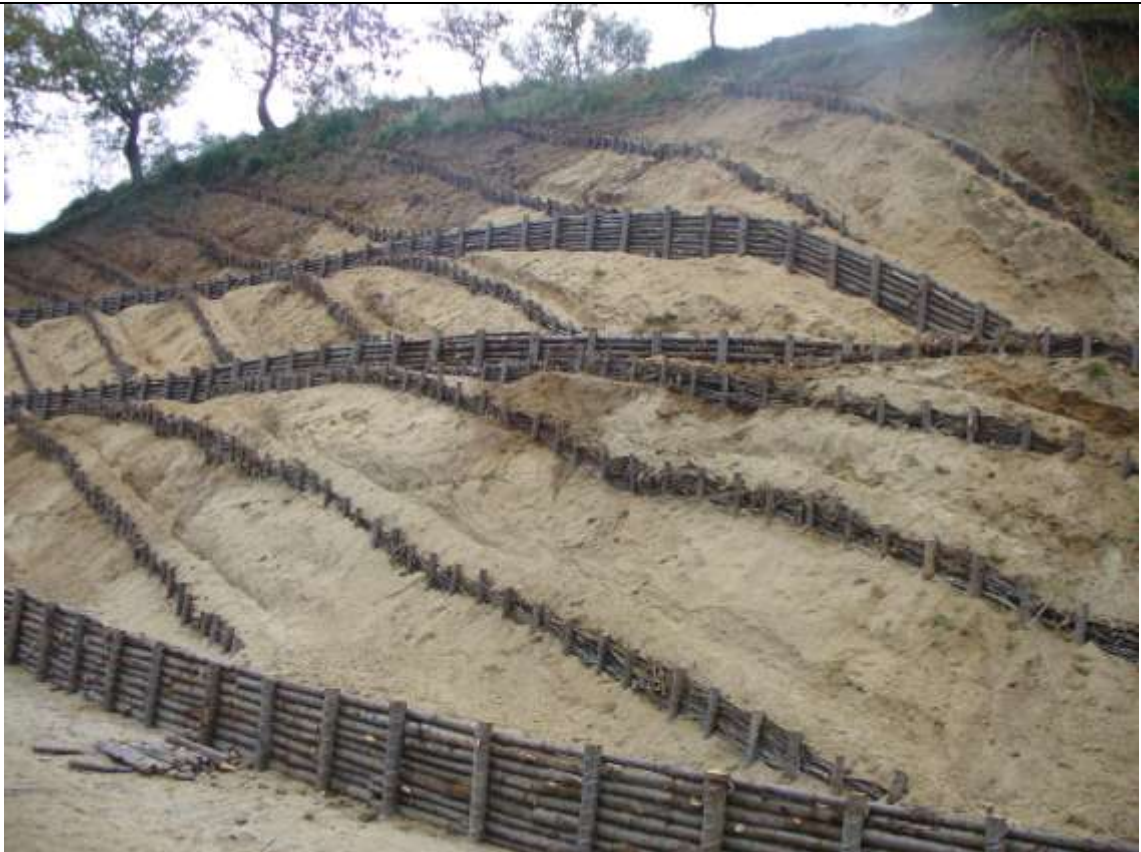
COMUNE DI VIBO VALENTIA – PISCOPIO – SISTEMAZIONE SCARPATA IN FRANA – CAMPO SPORT
