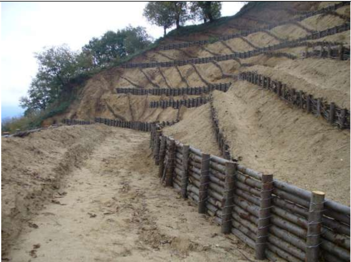
COMUNE DI VIBO VALENTIA – PISCOPIO – SISTEMAZIONE SCARPATA IN FRANA – CAMPO SPORT
